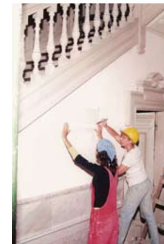
LA REPARACIÓN DE LA ESCALERA DE ENTRADA MANTIENE EL CRITERIO
